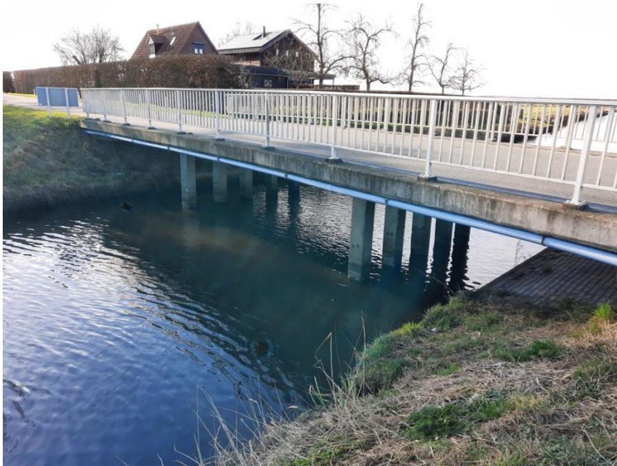
Figuur 1 - foto huidige situatie brug
