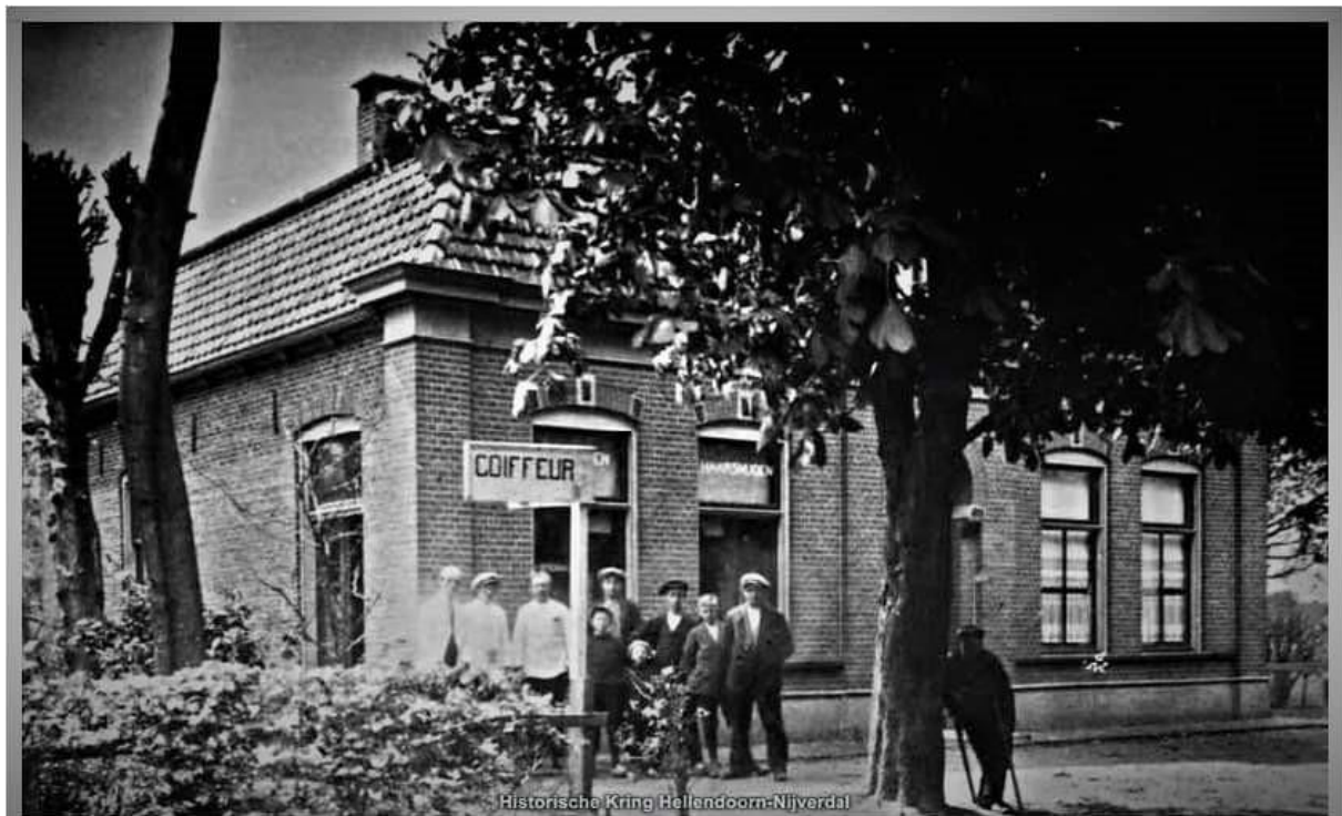
Afbeelding 2.2 het pand aan de Wilhelminastraat 58. Bron: historische kring Nijverdal.
