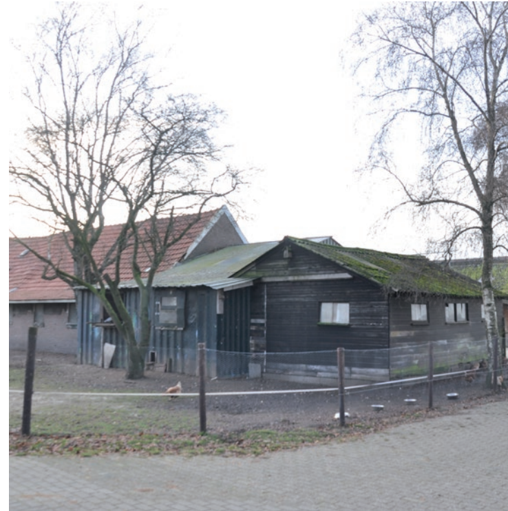
Gebouwen behorend bij nummer 3 doen verwaarloosd aan en zijn allemaal met elkaar verbonden
