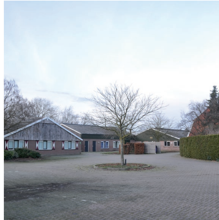
Bebouwing en verhardingen overheersen op het erf
