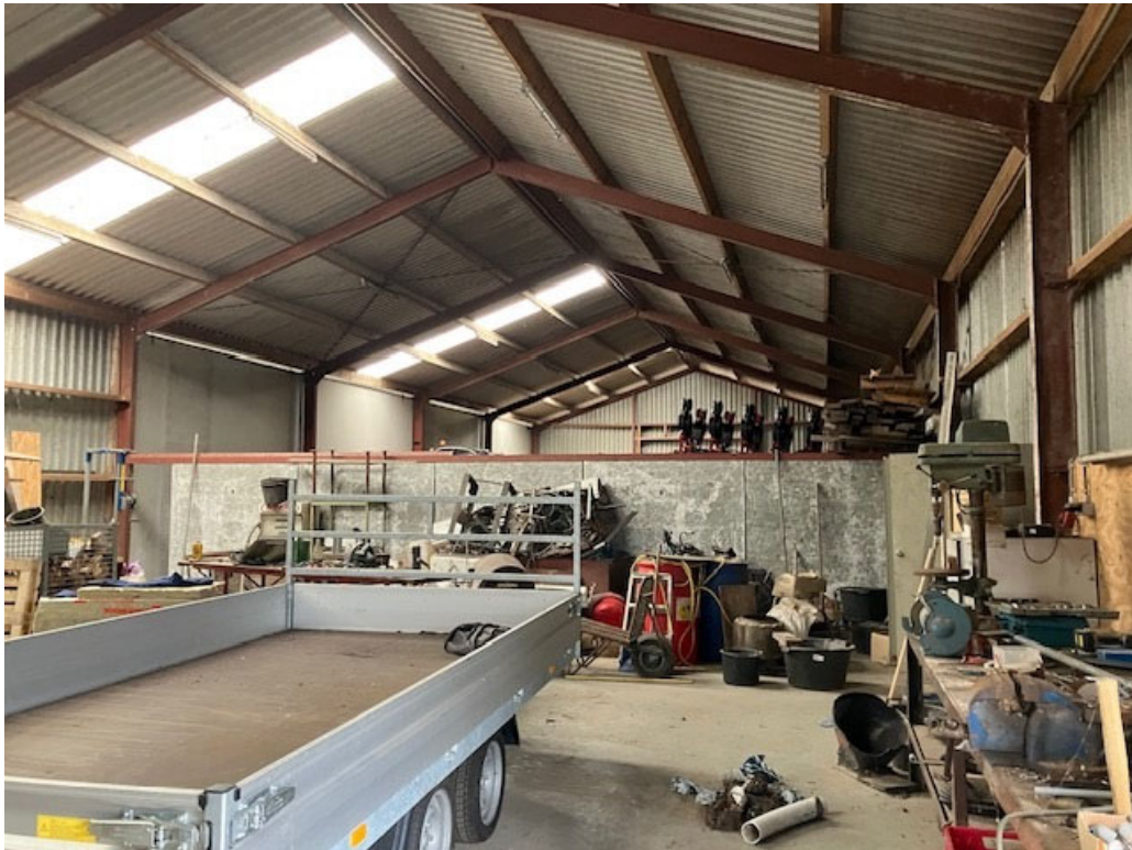
• Afbeelding 23: Binnenzijde te slopen loods
