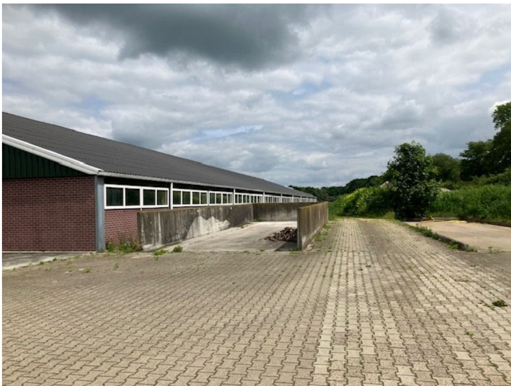
• Afbeelding 24: Op deze locatie en links daarvan worden 3 nieuwe woningen gebouwd
