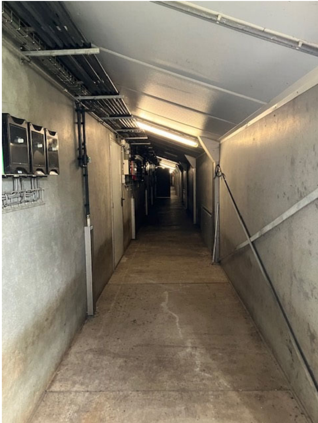
• Afbeelding 14: Centrale gang
