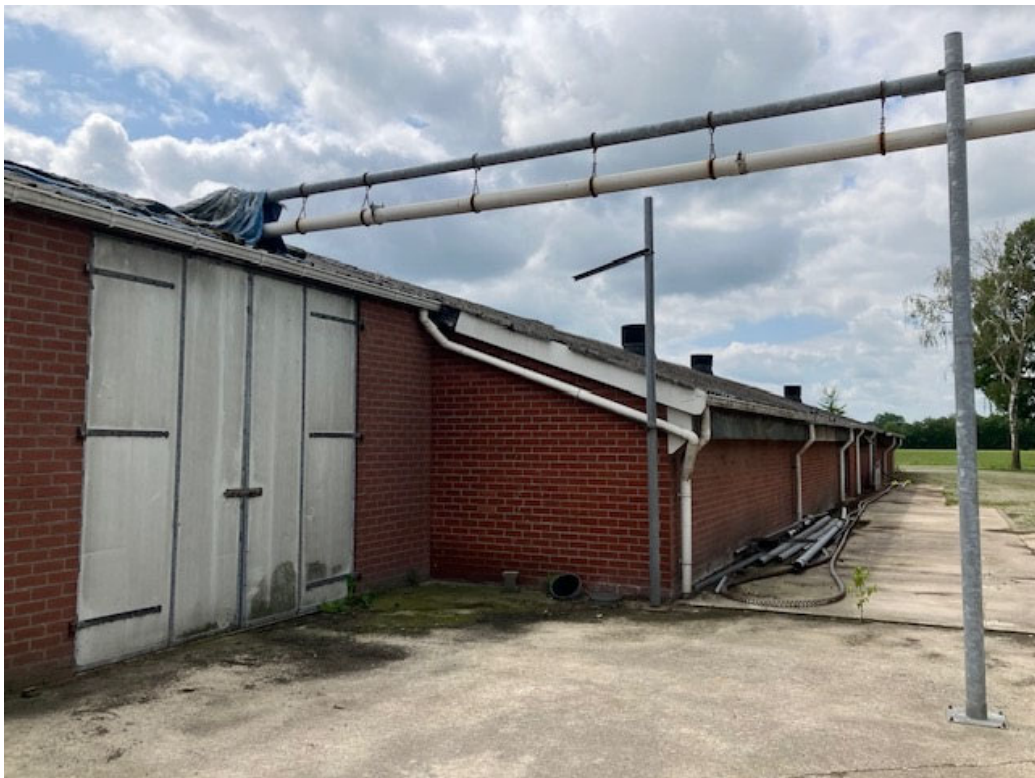
• Afbeelding 20: Te slopen stal
