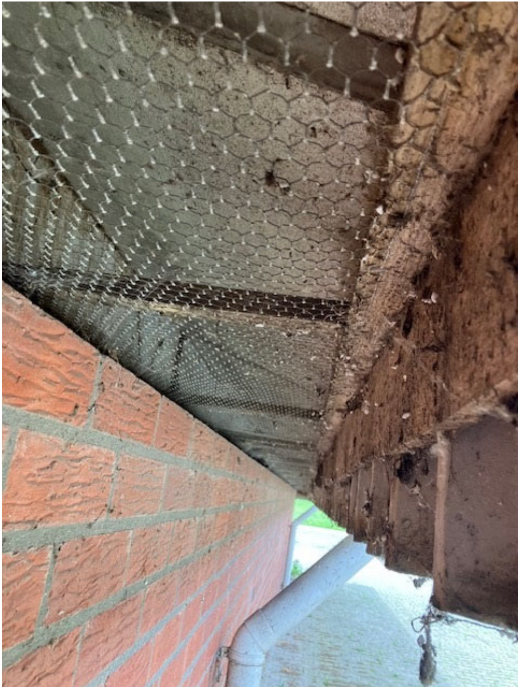
• Afbeelding 22: Luchtinlaat dicht gemaakt met gaas
