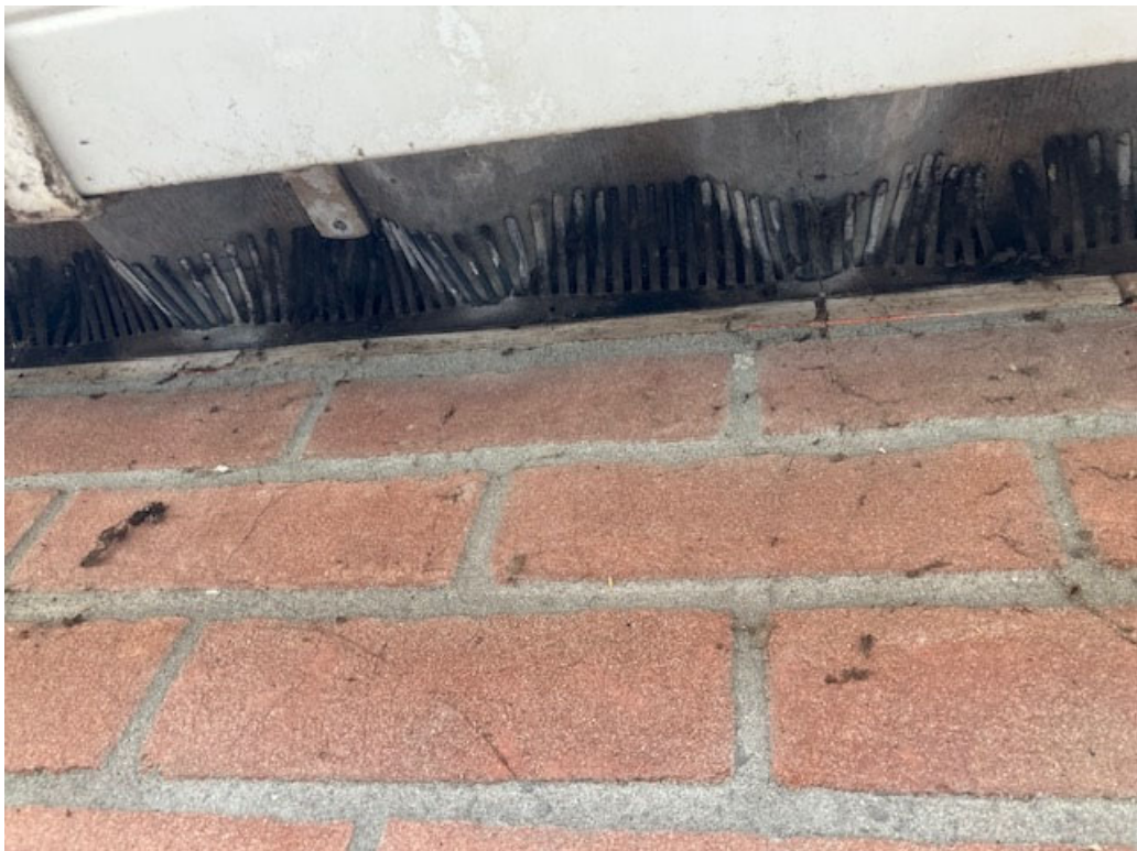
• Afbeelding 6: Alle aansluiting van muur en dak zijn dicht gemaakt met vogelschroot
