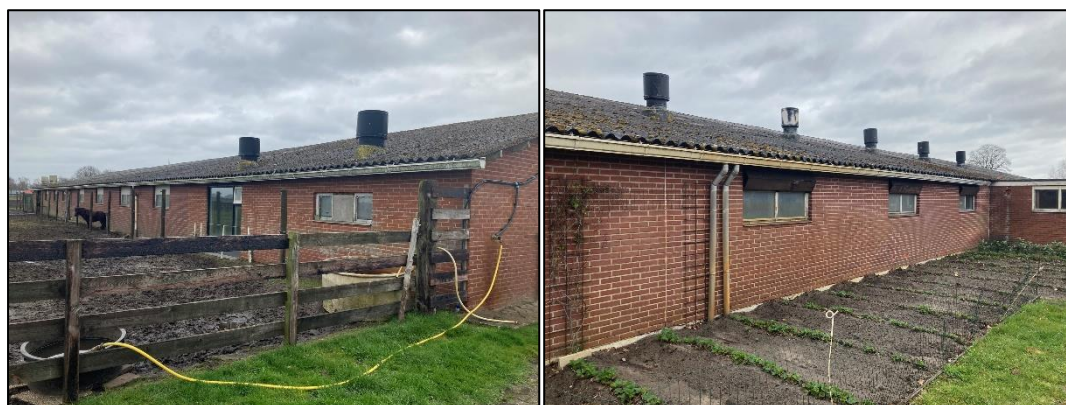
Figuur 2.8 (links) en 2.9 (links): Impressie van de te slopen stallen.
