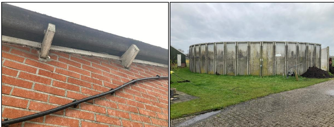
Figuur 2.12 (links): De bebouwing heeft geen daklijsten met holle ruimten erachter en sluit zeer goed aan op de gevels; Figuur 2.13 (rechts): Impressie van de mestilo.
