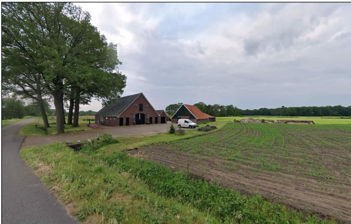
Afbeelding 2.2 Straatbeeld plangebied vanaf Derkingsweg (Bron: Google Street View; mei 2022)
