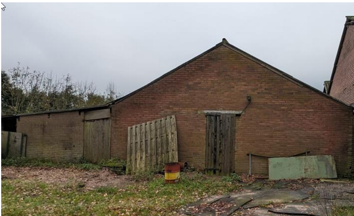
Nr. 2 Te slopen stal
