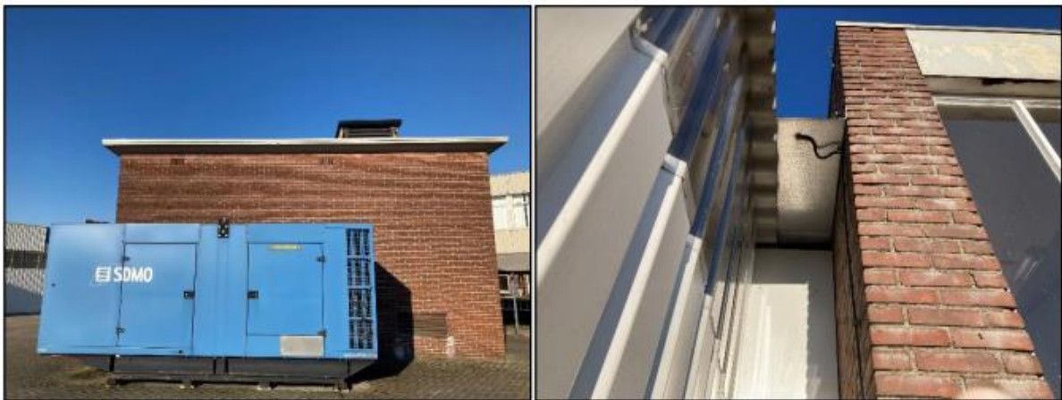
Figuur 2b: Impressie van het elektriciteitshuisje aan de zuidwestelijke zijde van het plangebied (links). Impressie van de verbinding tussen het gebouw aan de zuidzijde en de hal aan de zuidwestzijde (rechts).
