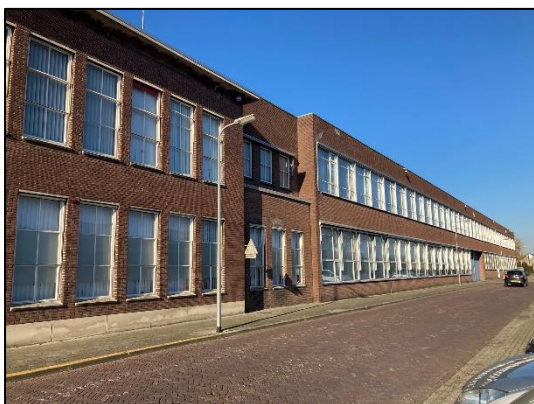
Figuur 2.3 (links): Impressie van de voorgevel van het gebouw gezien vanaf de Parallelweg, de daklijst van dit gebouw vertoont geen kieren en is volledig gemaakt van beton; Figuur 2.4 (rechts): Zuidwestelijke gevel van het gebouw met daarvoor een fietsenstalling
