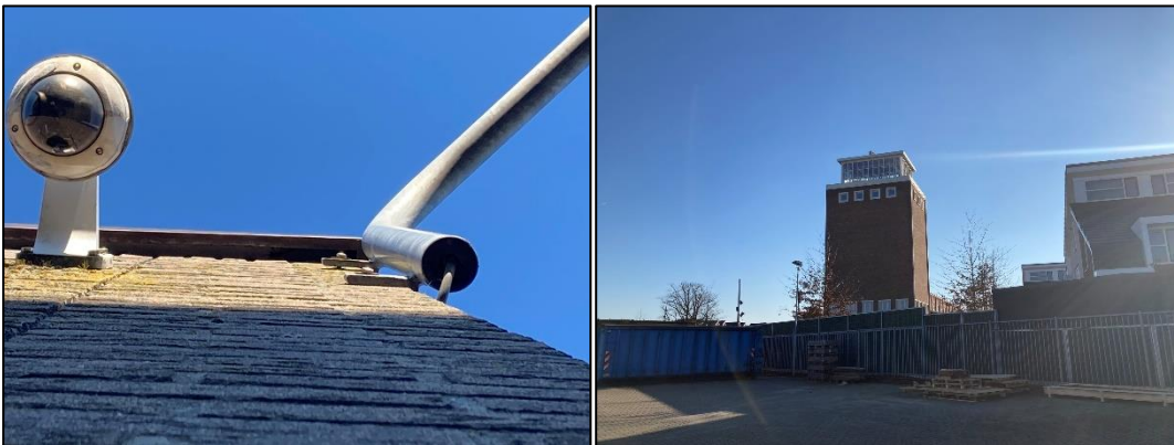
Figuur 2.9 (links): De bakstenen muren van de opslag hebben kieren bij de daklijsten; Figuur 2.10 (rechts): Het uitzicht op de toren van Parallelweg 4 vanaf de parkeerplaats.
