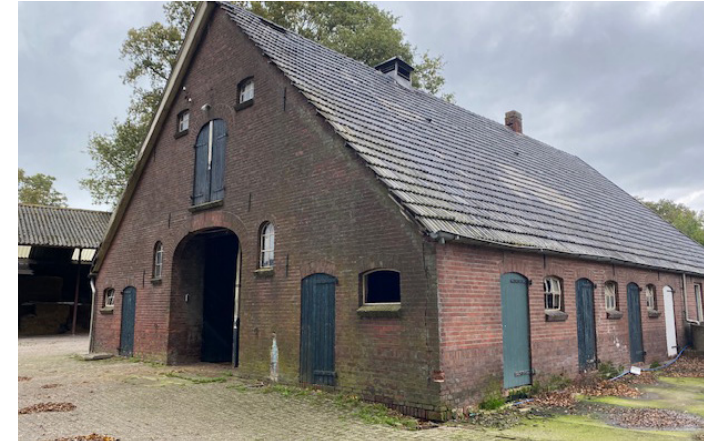
Achterzijde oorspronkelijke karakteristieke boerderij
