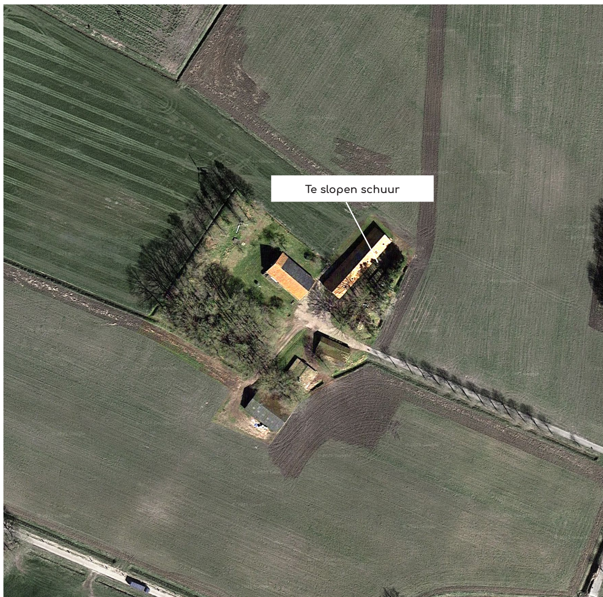
Erf aan de Benteloseweg 41, met de te slopen schuur.
