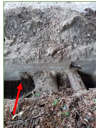
Opsluitband is aangepast aan de aanwezige gestelwortels.
