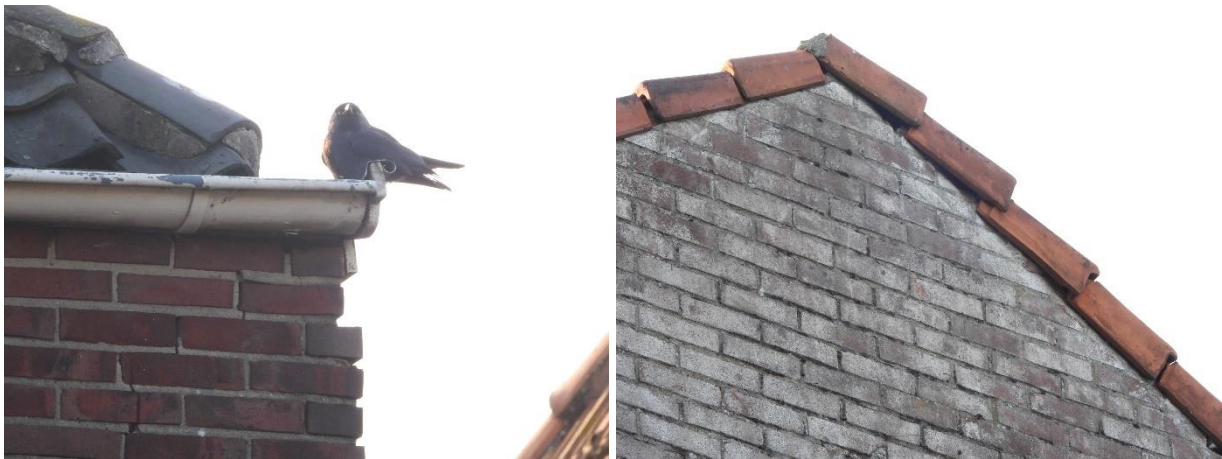
Foto links; Er nestelen kauwen in de te slopen bebouwing. Foto rechts; openingen onder de dakpannen bieden gierzwaluwen de kans een nestplaats te bezetten onder de dakpannen.
