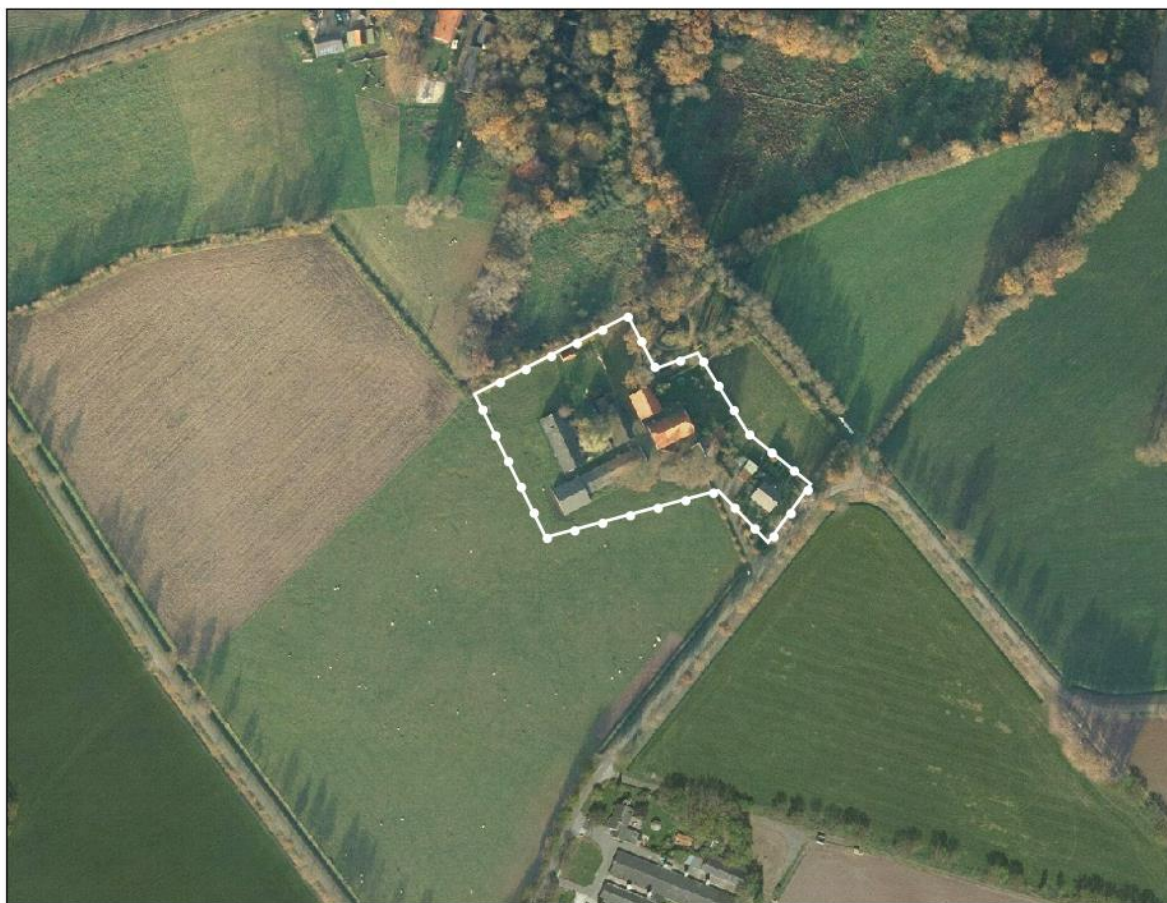
Figuur 2.4 Huidige situatie locatie Ensinkweg 5-7 (Bron: provincie Overijssel)
