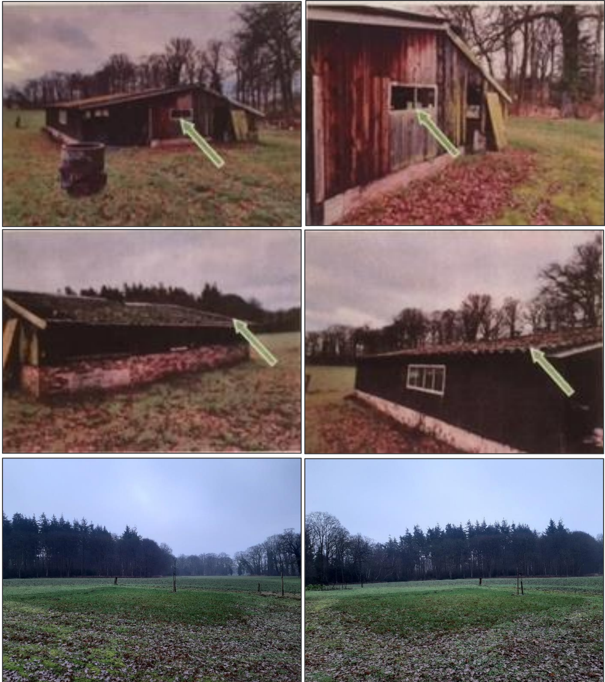
Afbeelding 3. Enkele foto's van de gesloopte schuur Beldershoekweg, bovenste vier foto's zijn afkomstig uit het asbestonderzoek.
