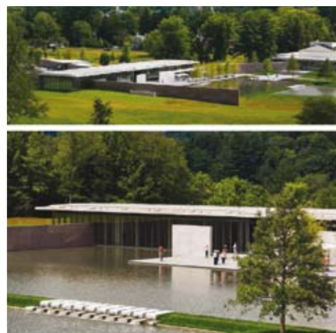
zichtbaar stromend water in meerdere niveaus
