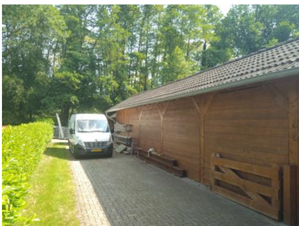
De dakpannen van de schuur sluiten naadloos op elkaar aan.
