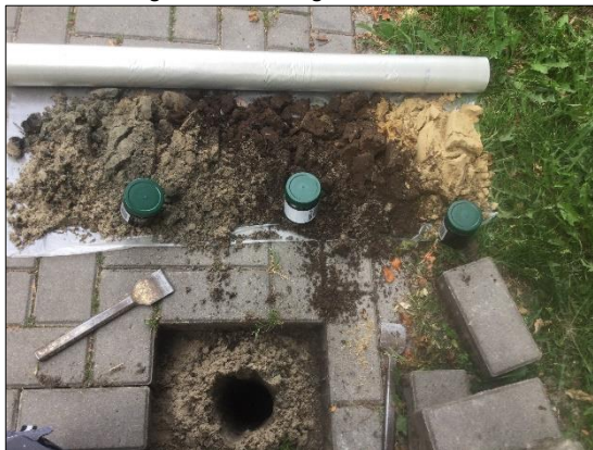
Foto 2: boring 2 (d.d. 17 augustus 2022)
