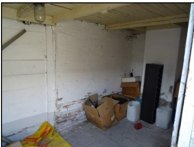
Figuur 12. Binnenkant schuur.
