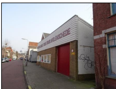
Figuur 3. Hoofdingang van het bedrijfspand aan de noordzijde van de onderzoekslocatie.
