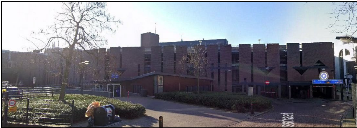
Afbeelding 2.3 Gevel 2022 achterzijde ABN
