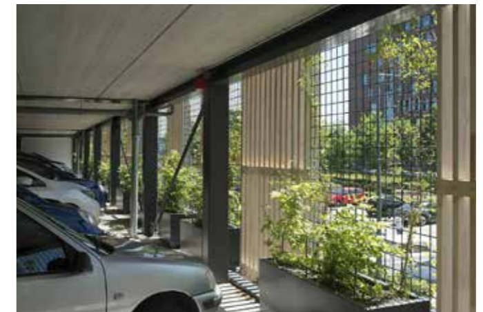
Groene gevel voor de Stationsgarage
