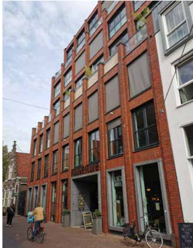
Baksteengevel met een rijke detaillering en (verticale) geleiding
