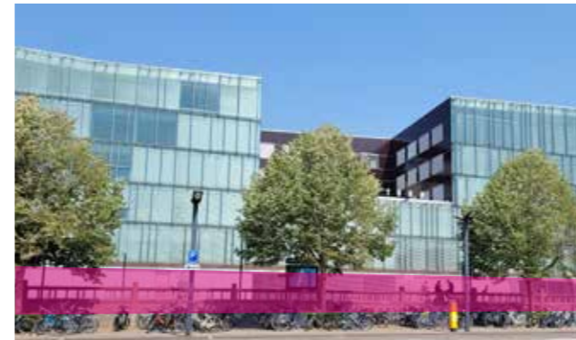
Het Stadskantoor staat met de achterzijde (kort) naar het stationsplein gericht.
