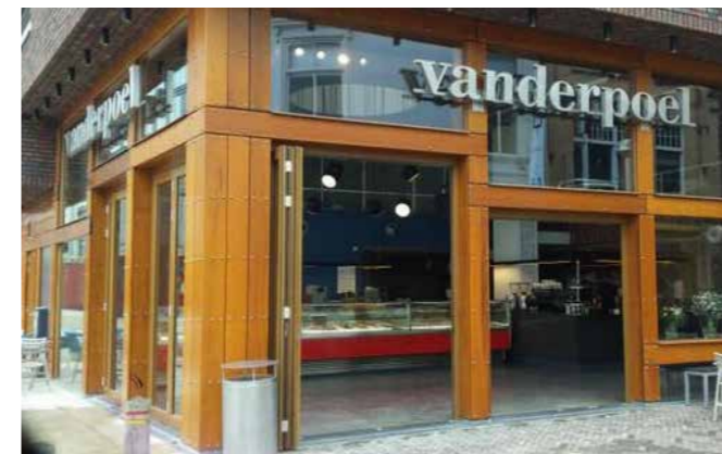
Op locatie Stationsplein/ Brammelerdwarstraat wordt de plint de hoek omgezet.
