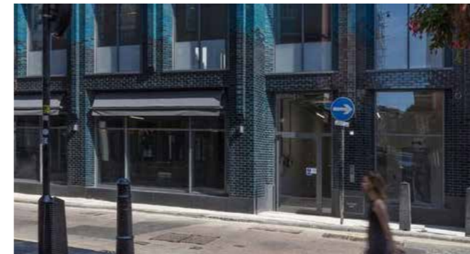
Geleiding en verspringing in de gevel
