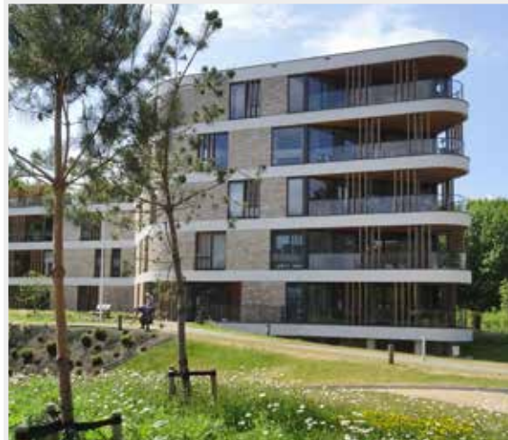
Entreegebouw aan de Gronausestraat accent in hoogte
