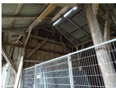
Figuur 2.7 Binnenzijde van gebouw 3.
