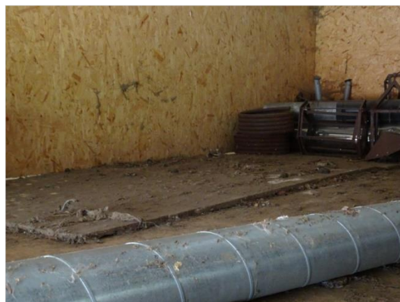
Figuur 5.3 Braakballen op de vloering van gebouw 3.
