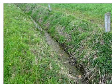
Figuur 2.14 Sloot aan de noordwestzijde van de onderzoekslocatie.
