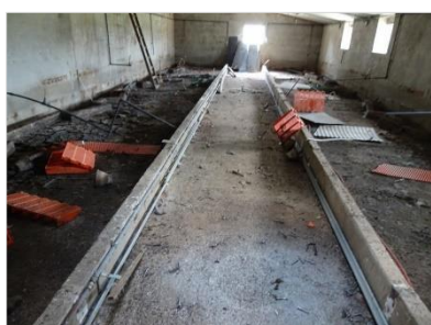
Figuur 2.12 Binnenzijde van gebouw 5.
