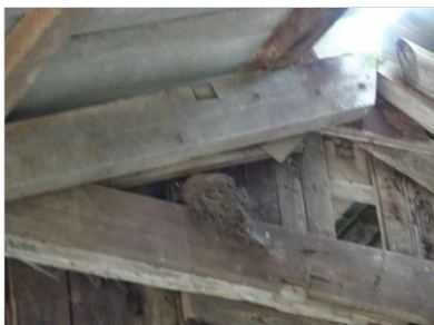
Figuur 5.4 Boerenzwaluwnest in gebouw 3.
