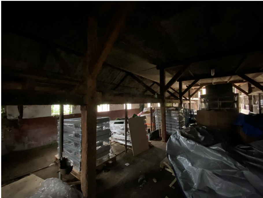
De veestalling aan de rechter zijde vanaf de straat gezien. Gebintstructuur met hilde en reppels.
