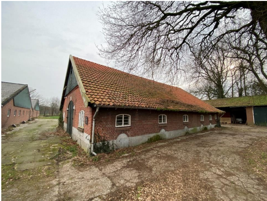
De zijgevel aan de kant van de boerderij met de opvallende halfroond getoogde openingen onder de betonramen die later zijn dicht gezet.
