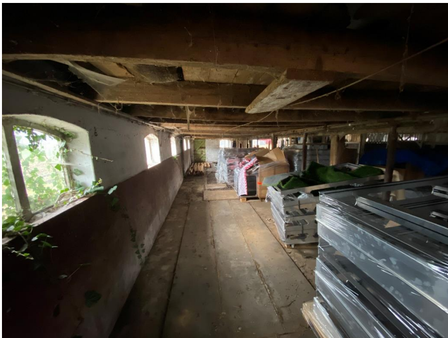
Veestalling onder de hilde.
