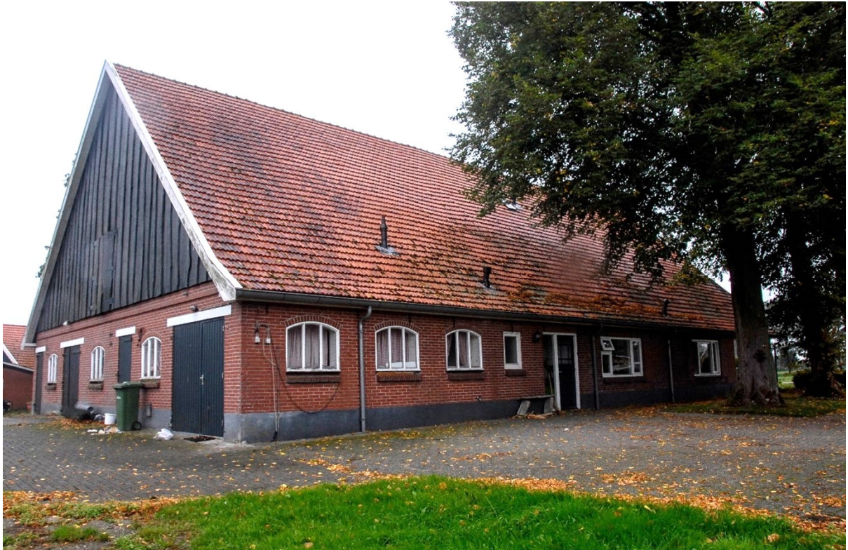
Johannahoeve westzijde, bedrijfszijde.
