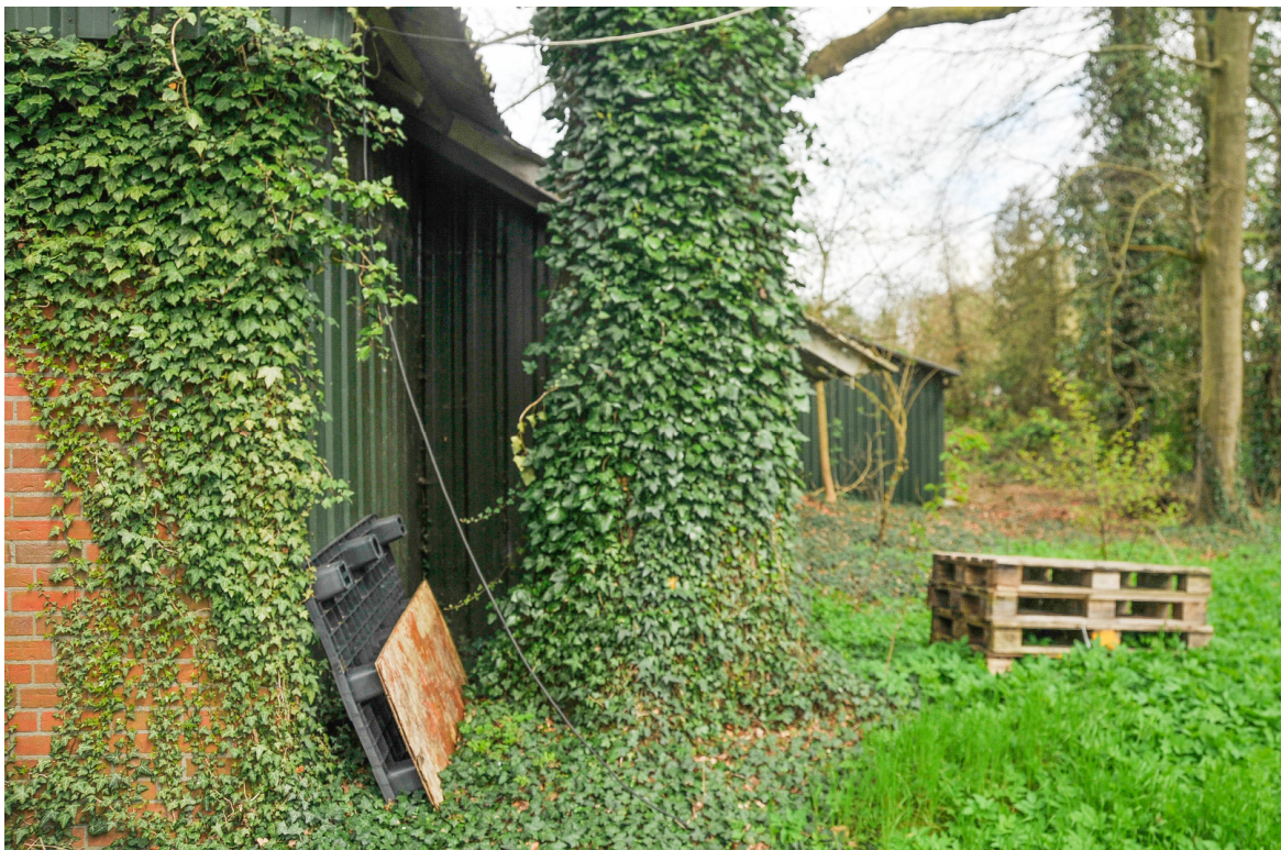
Johannahoeve: te handhaven- en vrij te stellen eiken zuidelijk van de bestaande schuren aan de Hoge Boekelerweg.
