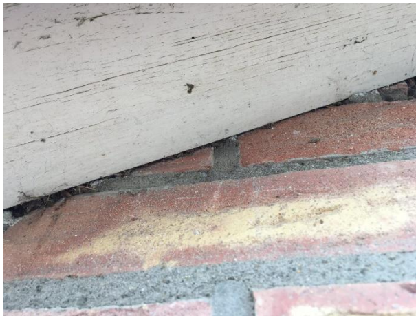
De betimmering van het dak overstek sluit naadloos aan op de buitengevels.
