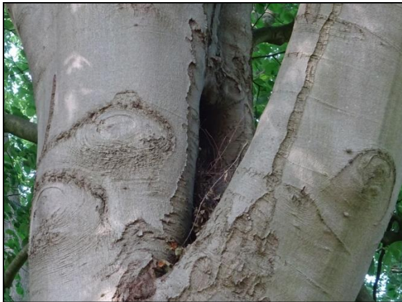
Figuur 10. Holte in boom nabij te realiseren autogarage.
