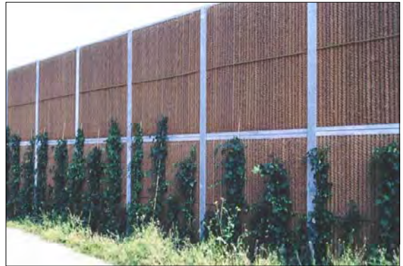
Geluidsschermb te Kerken, lengte 105m, 4 meter hoogte
