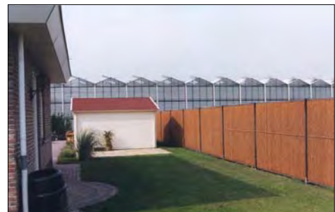
Kokowall geluidsschermb te Wateringen, l=70m 2m hoogte
