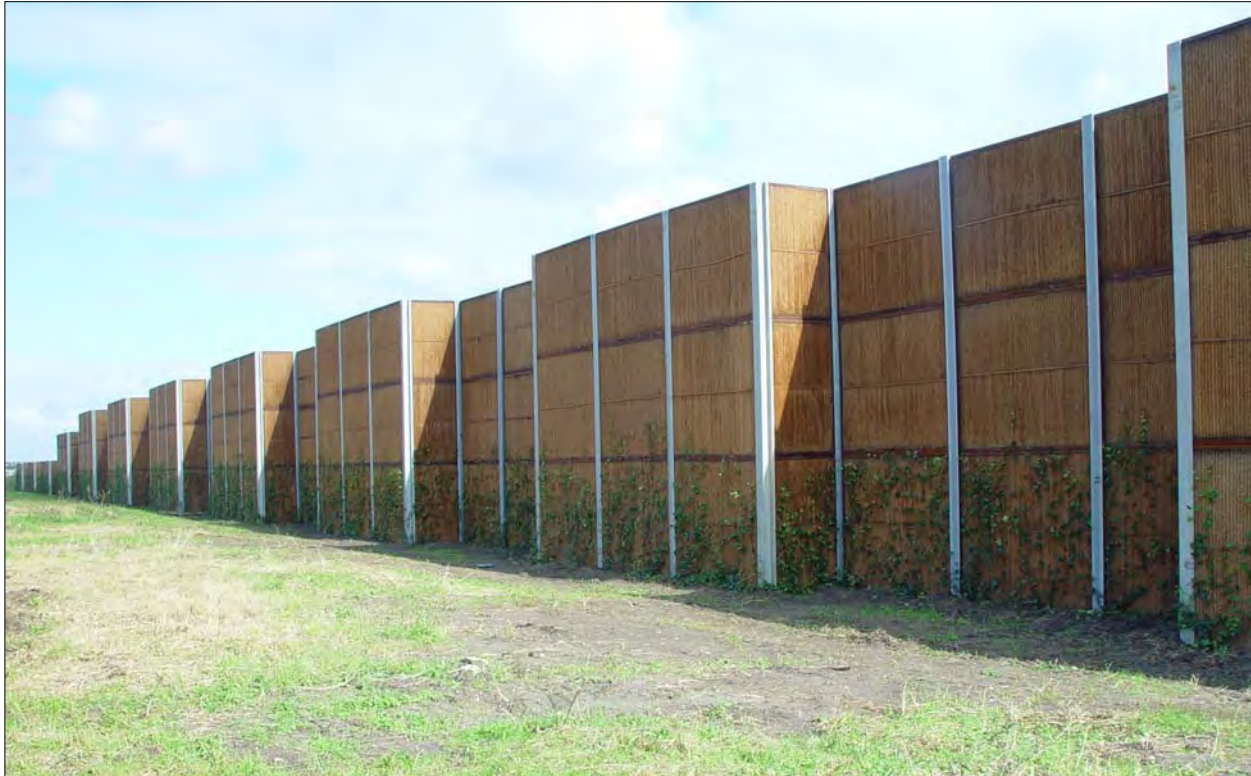
Kokowall geluidsscherm 3 - 6 m hoogte, lengte 200m te Zoetermeer
