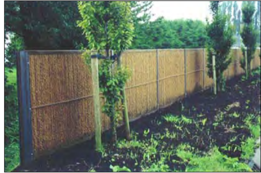
Kokowall geluidsschermb te Rijssenhout, l=75m 1,5m hoogte
