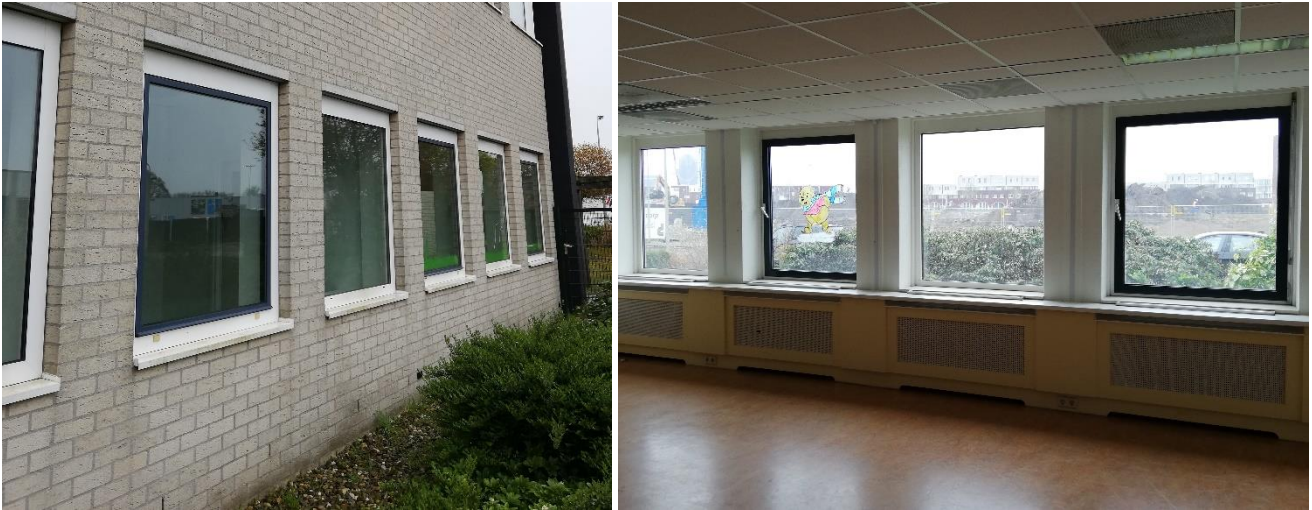
figuur 3 | Gevel- en binnenaanzicht van de bestaande gevelopeningen (nabij het berekende deel).
