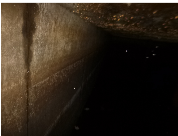
Inspectie uitpandige mestkelder via pompgat
