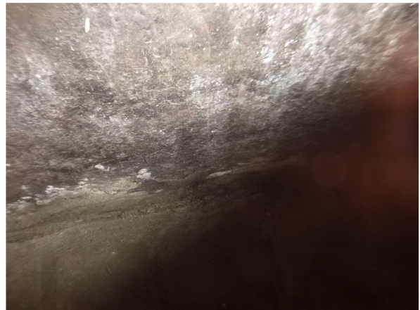
Inspectie mestkelder via rooster
