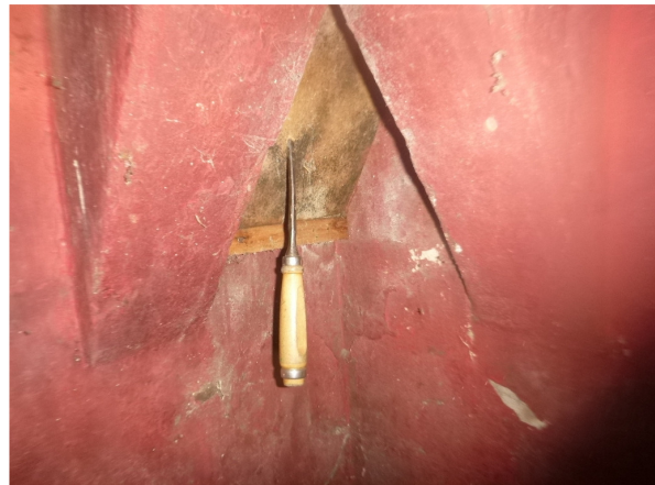
Inspectie plaatmateriaal onderzijde schoorsteen
