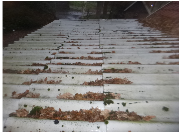
Asbestvrije NT-golfplaten op dak aanbouw
