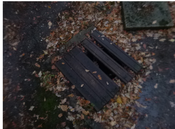
Inspectie uitpandige mestkelder via pompgat
