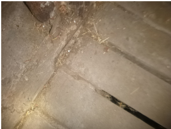
Inspectie mestkelder via rooster
