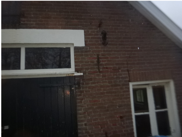
Inspectie gevel en kozijnen
