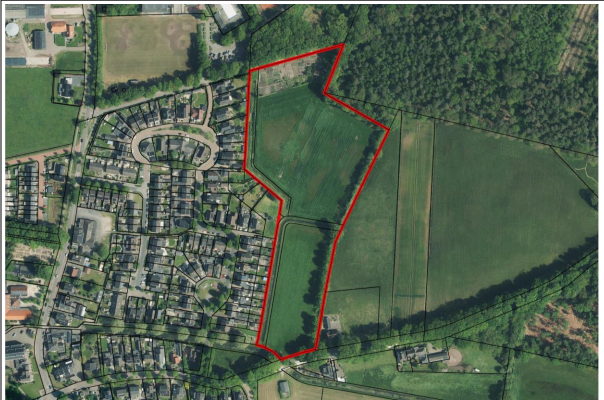
Figuur - Ligging en begrenzing besluitgebied op een luchtfoto, in combinatie met de kadastrale kaart
