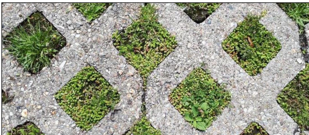
Figuur 5.7 Voorbeeld van halfverharding toepasbaar op parkeerplaatsen. Foto: Ecogroen.
