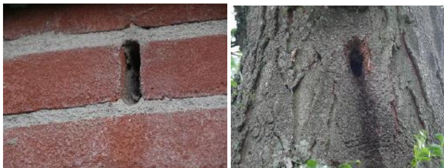
Aangetroffen potentiële verblijfplaatsen in het gebouw en bomen (afbeeldingen uit rapportage Veldbiologische Werken).
