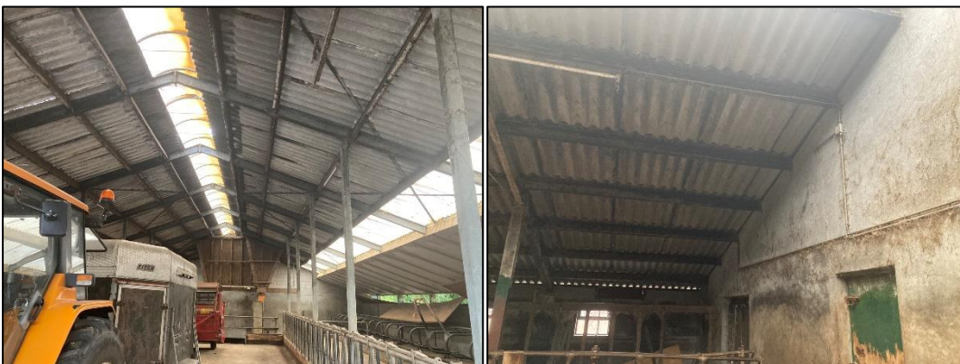
Figuur 6.2 (links): De binnenkant van de ligboxenstal met aan de onderste helft van het dak goed aansluitende dakisolatie. De bovenste helft van het dak heeft geen isolatie. Figuur 6.3 (rechts): De binnenkant van het dak van de jongveestal bevat geen isolatie.
