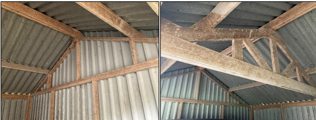
Figuur 6.1: De binnenkant van de overkapping die wordt gebruikt als garage.
