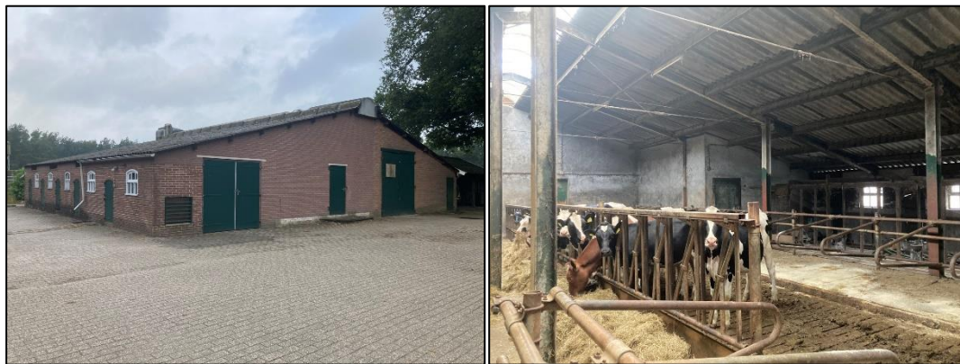
Figuur 2.3 (links): De jongveestal; Figuur 2.4 (rechts): De binnenkant van de jongveestal. De stalgebouwen zijn nog in gebruik en zien er netjes en goed bijgehouden uit.
