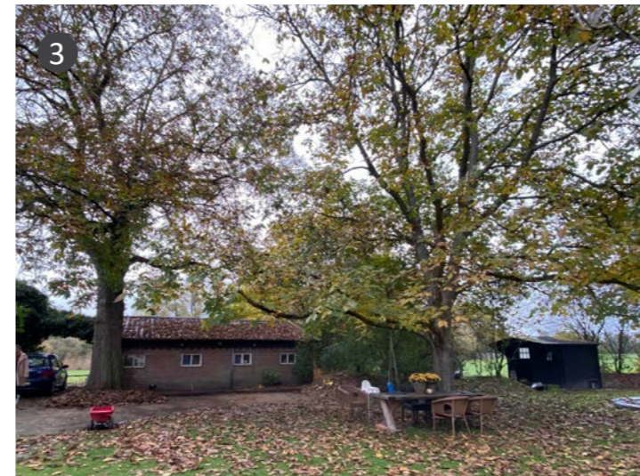
Solitaire bomen. Linker boom (kastanje) wordt aangetast door het bijgebouw.
