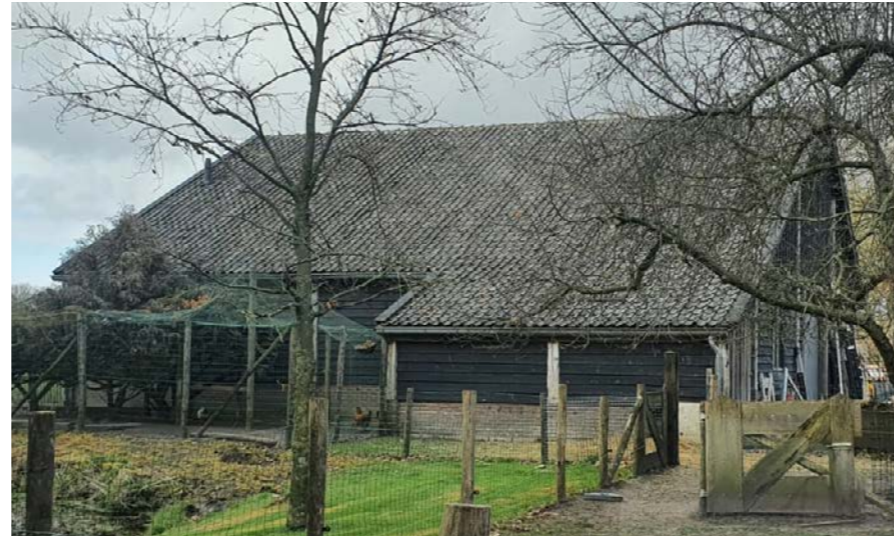
Houten wanden die gepotdekselt zijn.
