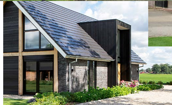
Houten staanders welke in contrast staan met de wanden.
