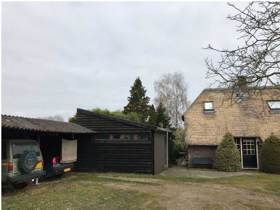
Schuur en overkapping aan de voorzijde langs de weg
