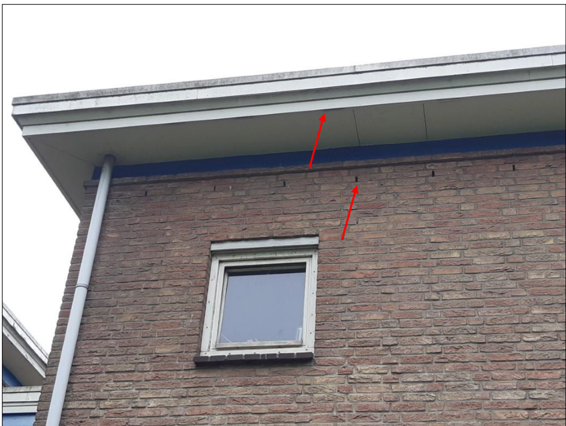
Figuur 4.1 Open stootvoegen in het metselwerk van het schoolgebouw en in het dakoverstek kunnen toegang bieden tot verblijfplaatsen van vleermuizen in de spouwmuur, ook de overstek biedt hiervoor mogelijkheden. Foto: ██████████, Ecogroen.
