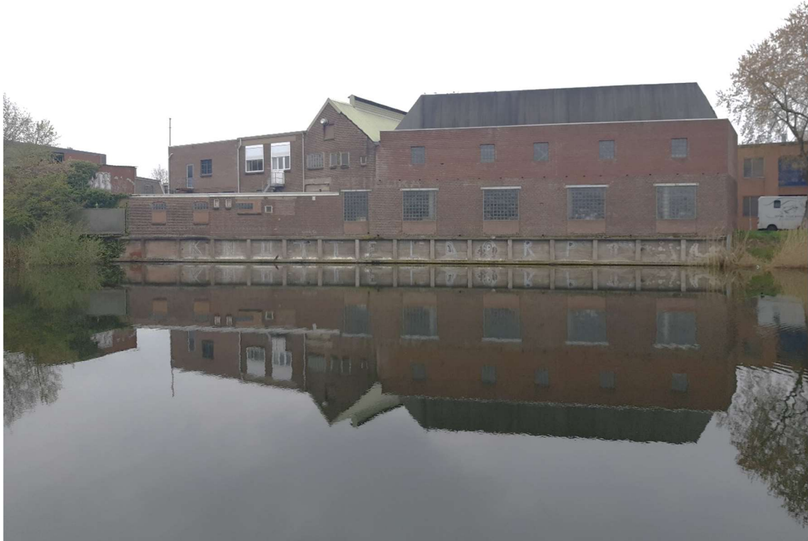
Figuur B5 Zicht op het plangebied vanaf de overzijde van de Buitensingel.
