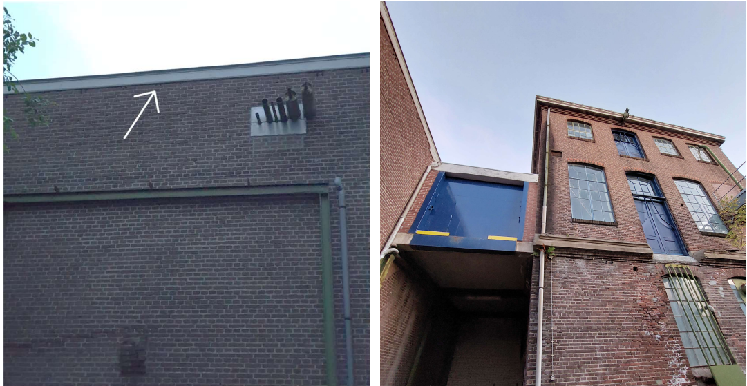
Figuur 4.4 Zomer- en paarverblijfplaats in de zuidwestgevel van de binnenplaats (witte pijl op linker afbeelding). Rechts de noordwest gevel van de binnenplaats, ter informatie (geen verblijfplaatsen vastgesteld).
