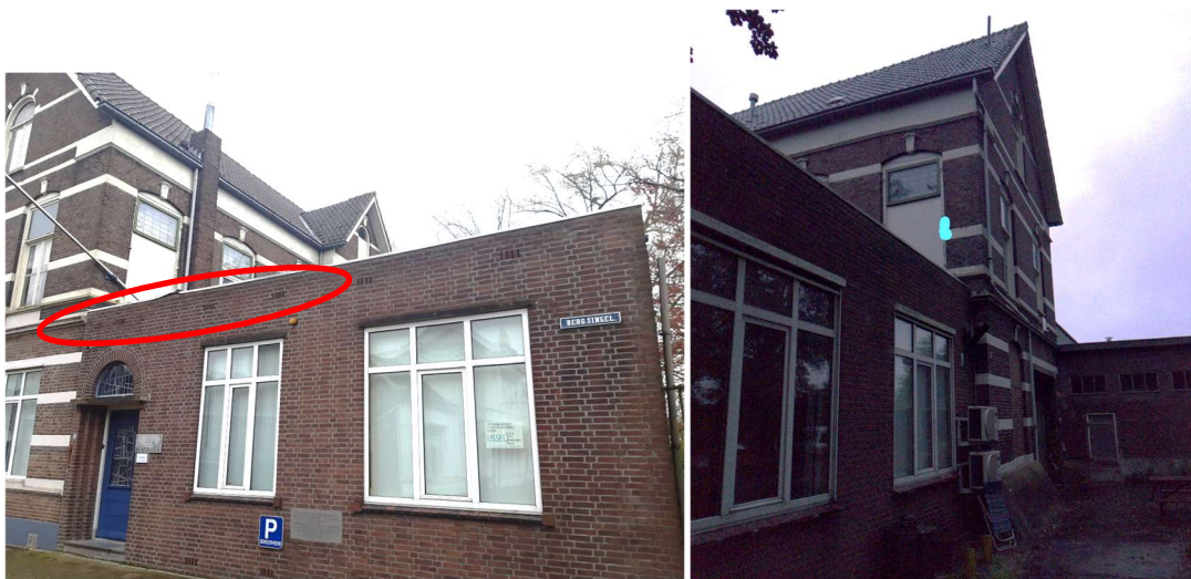
Figuur 4.3 Zomer- en paarverblijfplaatsen van gewone dwergvleermuis in de bebouwing van Bergsingel 2. Links: voorzijde (zomer- en paarverblijven). Rechts: achterzijde (zomerverblijf).
