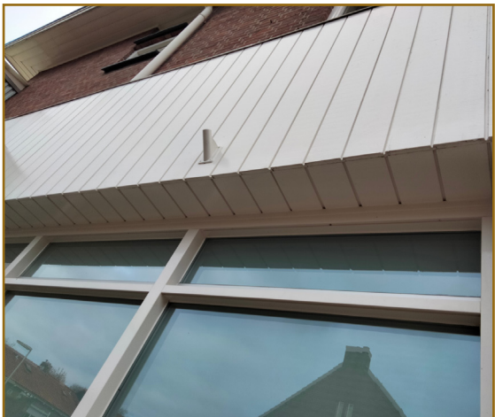
Afb. 2.4: De woningen bevatten geen spleten of openingen welke vleermuizen toegang tot geschikte tussenruimtes bieden.
