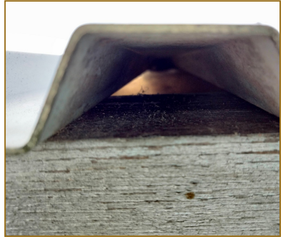
Afb. 2.2: De golfplaten rondom de sportschool bevatten openingen welke toegang bieden tot geschikte tussenruimtes en groot genoeg (> 1,5 cm) zijn voor gebouwbewonende vleermuizen.
