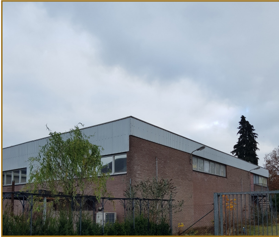
Afb. 2.1: Binnen het noorden van het plangebied is een sporthal aanwezig met rondom halfverhard terrein. rondom de bovenzijde van de muren zijn golfplaten aanwezig.
