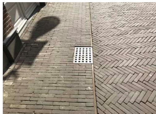
Overgang straatwerkverbanden, foto: Vleeshouwerstraat
