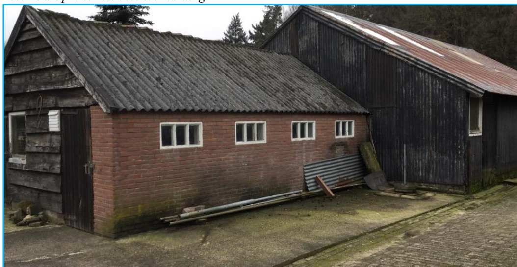
Foto 1: drupzone met betonverharding
