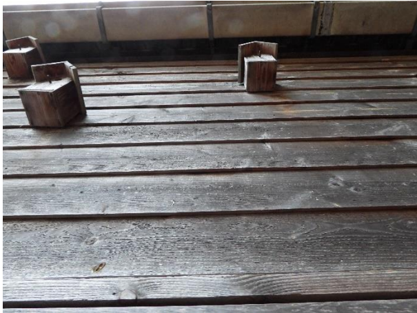
De planken sluiten strak op elkaar aan.
