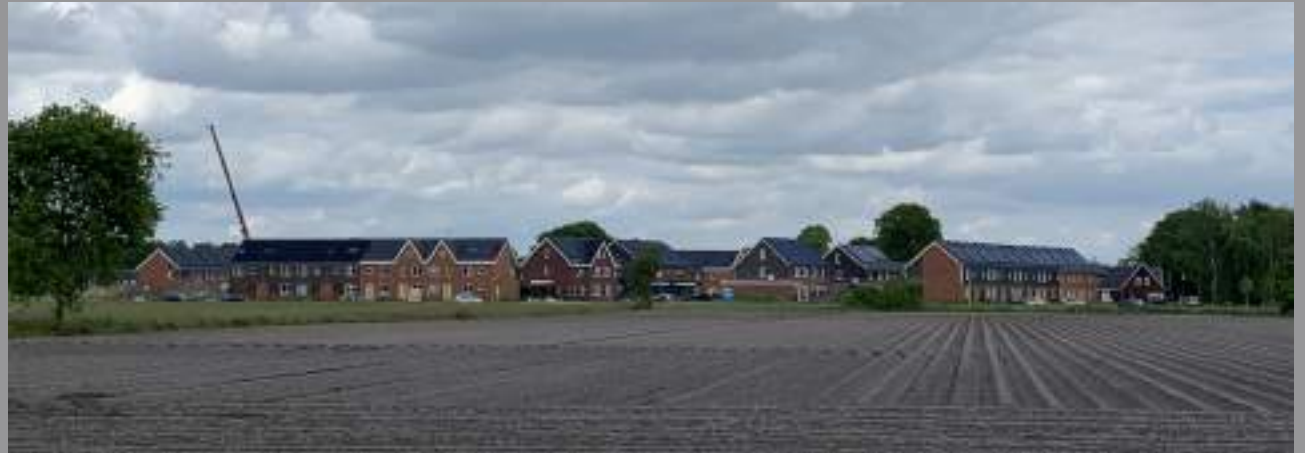
Zicht vanaf de Bouwhuisweg op deelgebied 1
