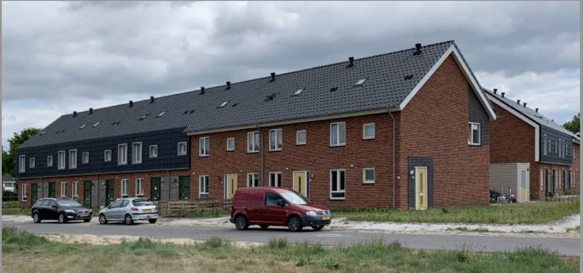
Een sterke verbijzondering waar een deel van de kap doorloopt in de gevel (2e fase Westerbouwlanden).
