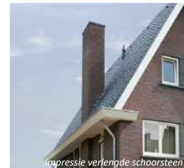
impressie verlengde schoorsteen
