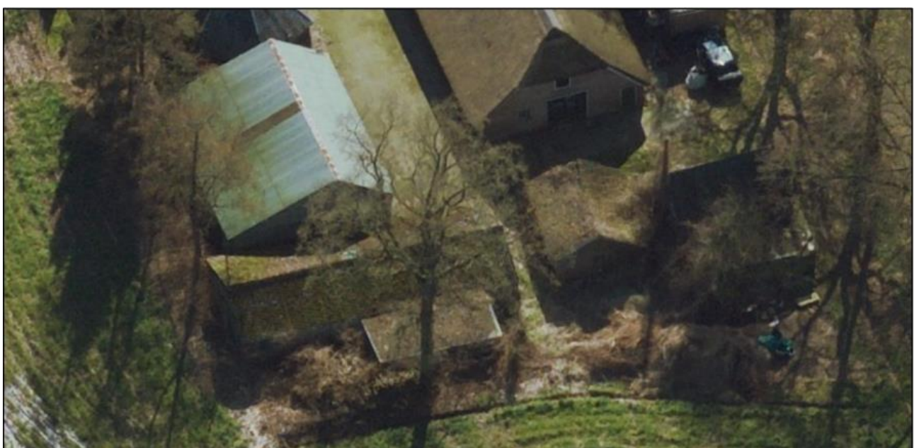
Figuur 2. Weergave van de te slopen gebouwen (Bron: Principeverzoek / Cyclomedia)
