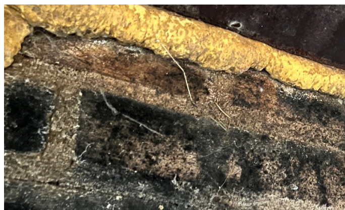
Afbeelding 10. Randen zijn bekleed met pur (aangebracht voordat de huidige eigenaren het perceel kocht)
