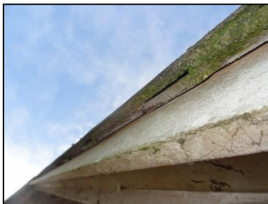
Figuur 15. Strak aansluitende kantpannen bedrijfswoning.
