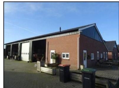
Figuur 5. Kantine en wagenloods gezien vanaf het noordoosten.
