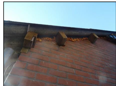
Figuur 17. Met vulschuim afgedichte stalgevel.
