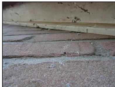
Figuur 16. Strak afgewerkte betimmering bedrijfswoning.
