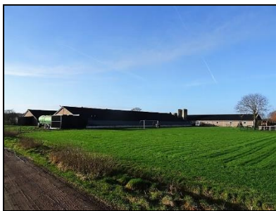
Figuur 3. Varkensstallen gezien vanaf het noordoosten.
