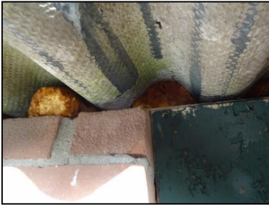
Figuur 12. Schuim onder dakplaten oostelijke stal.
