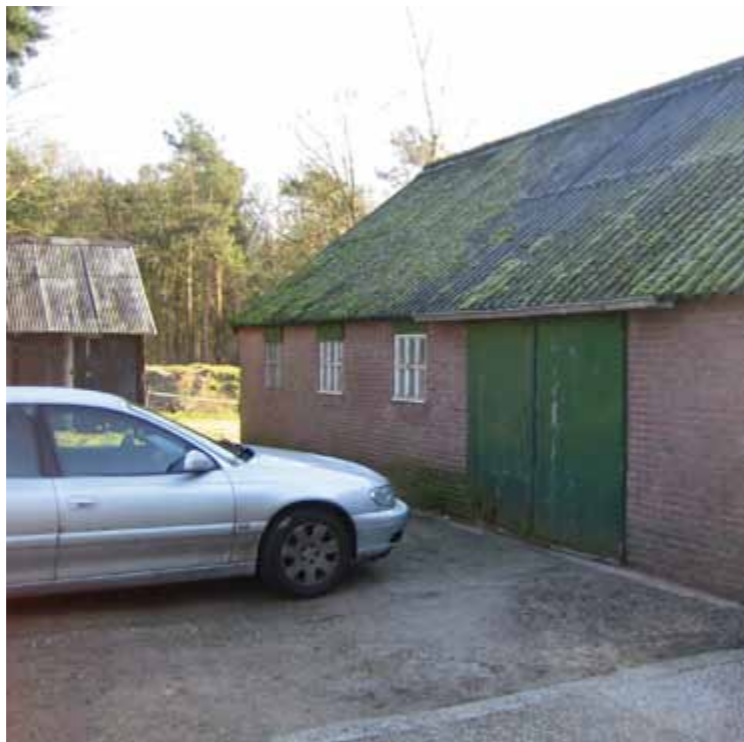
Schuur om te vormen tot appartementen
