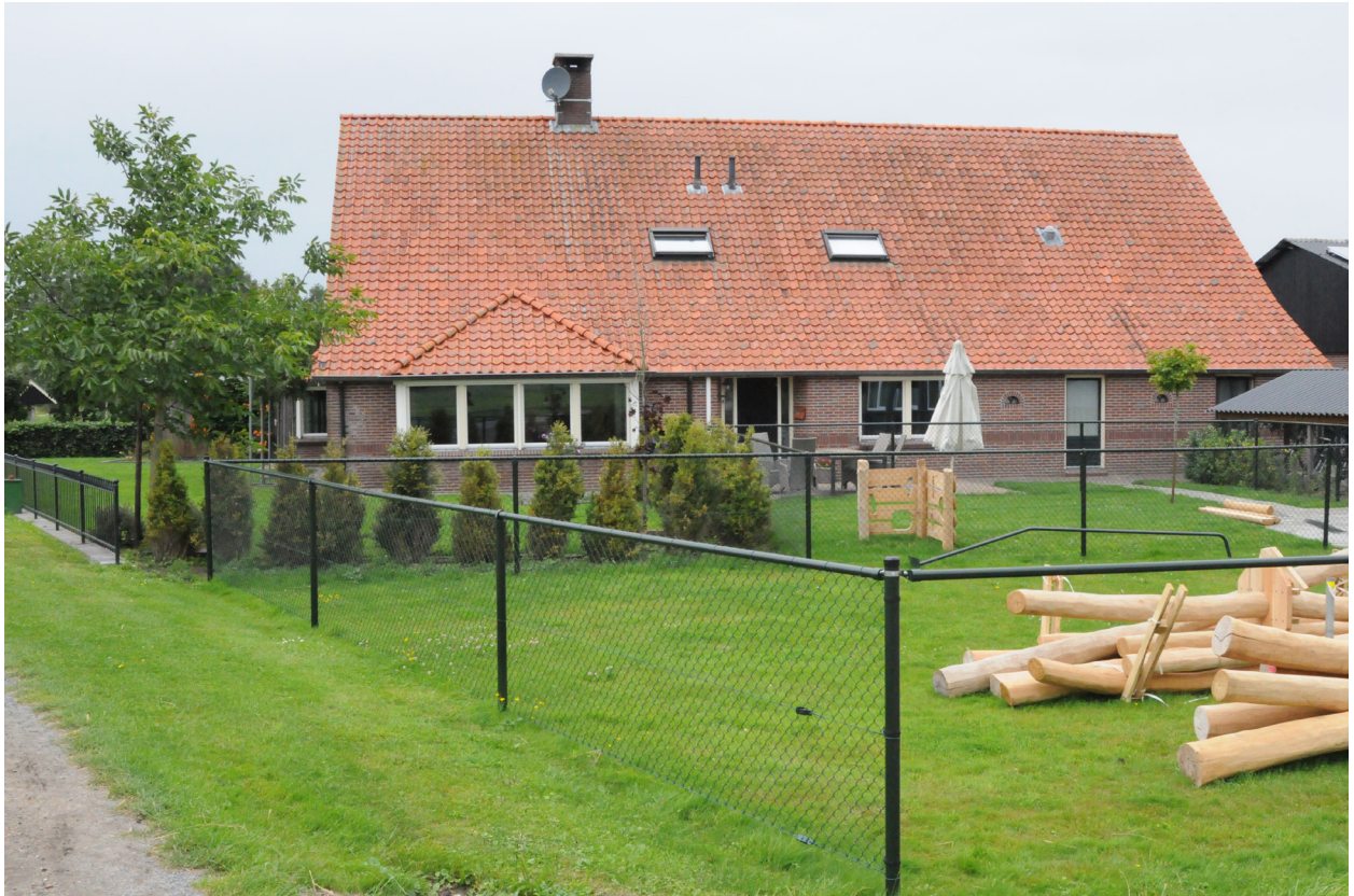
Afbeelding 3. Voormalige boerderijwoning op de voorgrond van het erf aan de Wetering.
